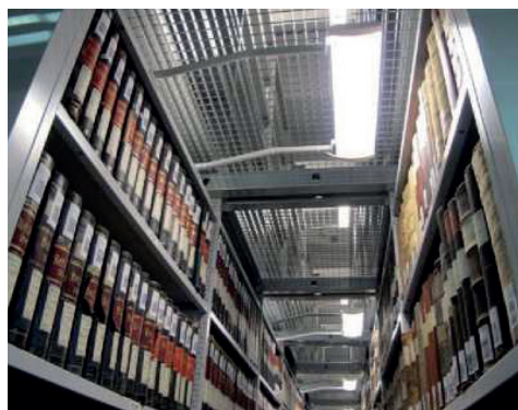
Oświetlenie zainstalowane bezpośrednio na regałach przesuwanych. Lampy zapalają się automatycznie pomiędzy rozsuniętymi rzędami regałów i gasną po ich zsunięciu. Archiwum Narodowe Danii w Kopenhadze (Rigsarkivet), Dania
