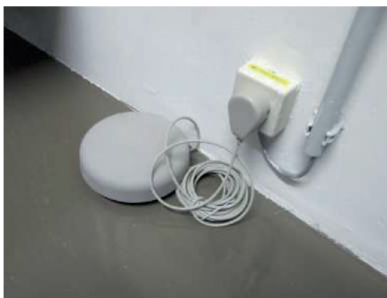
Czujnik systemu wykrywania wycieków wodnych w magazynie. Archiwum Regionu Rivierenland w Tiel (Regionaal Archief Rivierenland), Holandia
