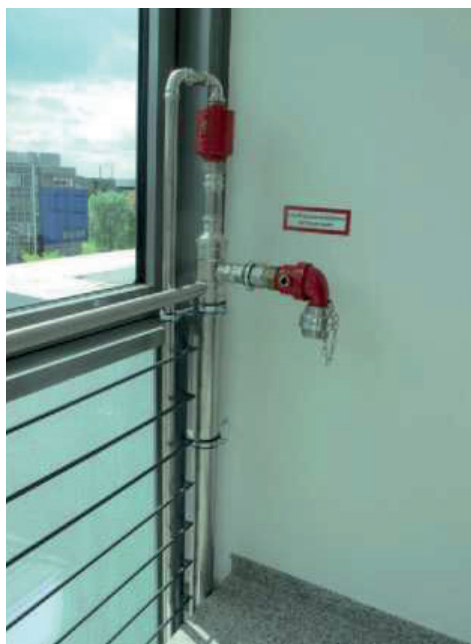
Pion hydrantu z zaworami na klatce schodowej w części magazynowej. Brandenburskie Główne Archiwum Krajowe w Poczdamie (Brandenburgisches Landeshauptarchiv), Niemcy
