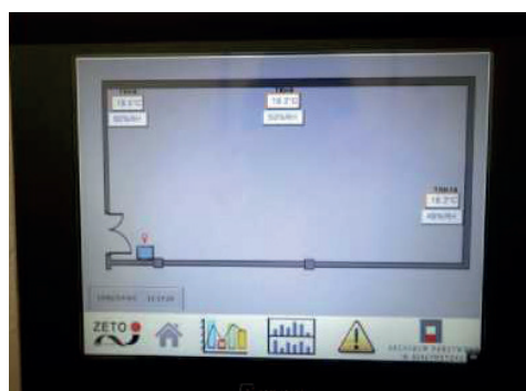
Ekran w magazynie archiwum pokazujący na bieżąco rozmieszczenie czujników klimatycznych w pomieszczeniu wraz z wynikami pomiaru temperatury i wilgotności. Archiwum Państwowe w Białymstoku
