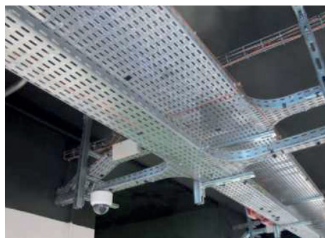
Przewody sieci elektrycznej, systemowej i inne instalacje prowadzone w zewnętrznych, podwieszonych pod sufitem korytarza, metalowych korytach. Instalacja jest łatwo dostępna, można ją uzupełniać, serwisować, wymieniać i czyścić. Archiwum Narodowe Estonii w Tartu (Noora Rahvusarhiiv), Estonia
